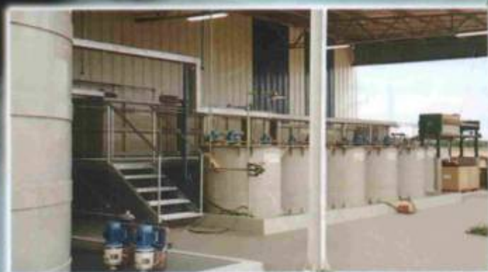
E.T.E.s. para 10m³/h (fosfatização com pintura cataforética)
